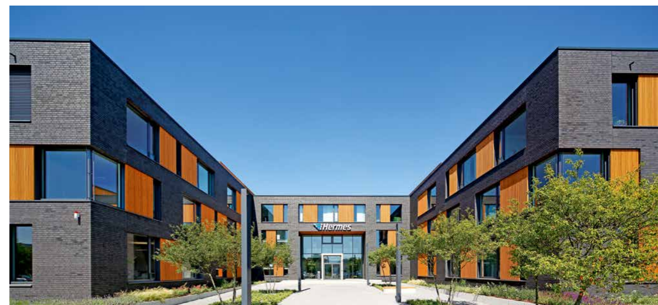
Dunkle Klinkerriemchen auf WDVS sind bauphysikalisch unproblematisch: SYDNEY
