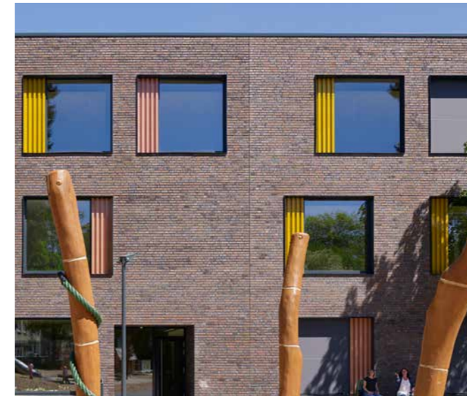
Die beiden Gebäudeteile werden mit einer durchgehenden Fuge getrennt, WIESMOOR kohle-bunt
