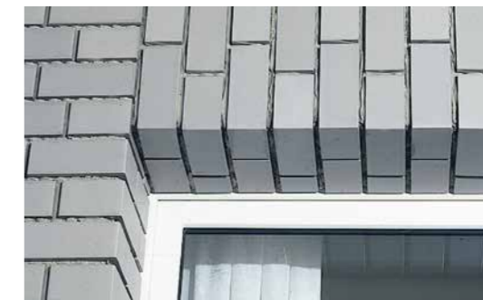
Ein mit Winkelriemchen und geschnittenen Flächenriemchen perfekt nachgebildeter Sturz
