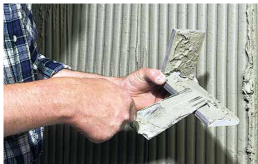
Kleberauftrag im kombinierten Verfahren („Floating-Buttering“)
