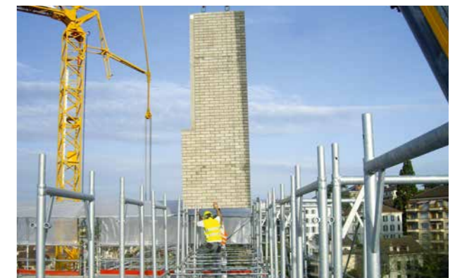
Ein Pilasterelement wird zur Montage durch das Gerüst hindurch abgelassen
