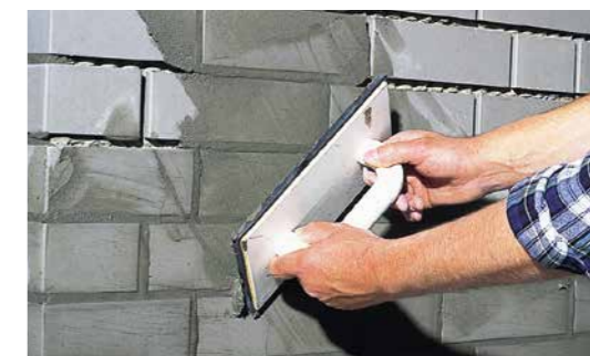
Im Schlämm-Verfahren werden die Fugen diagonal mit einem Putzbrett verfüllt
