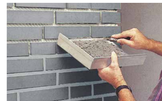
Sauberes Verfugen mit Fugeisen und Fugblech
