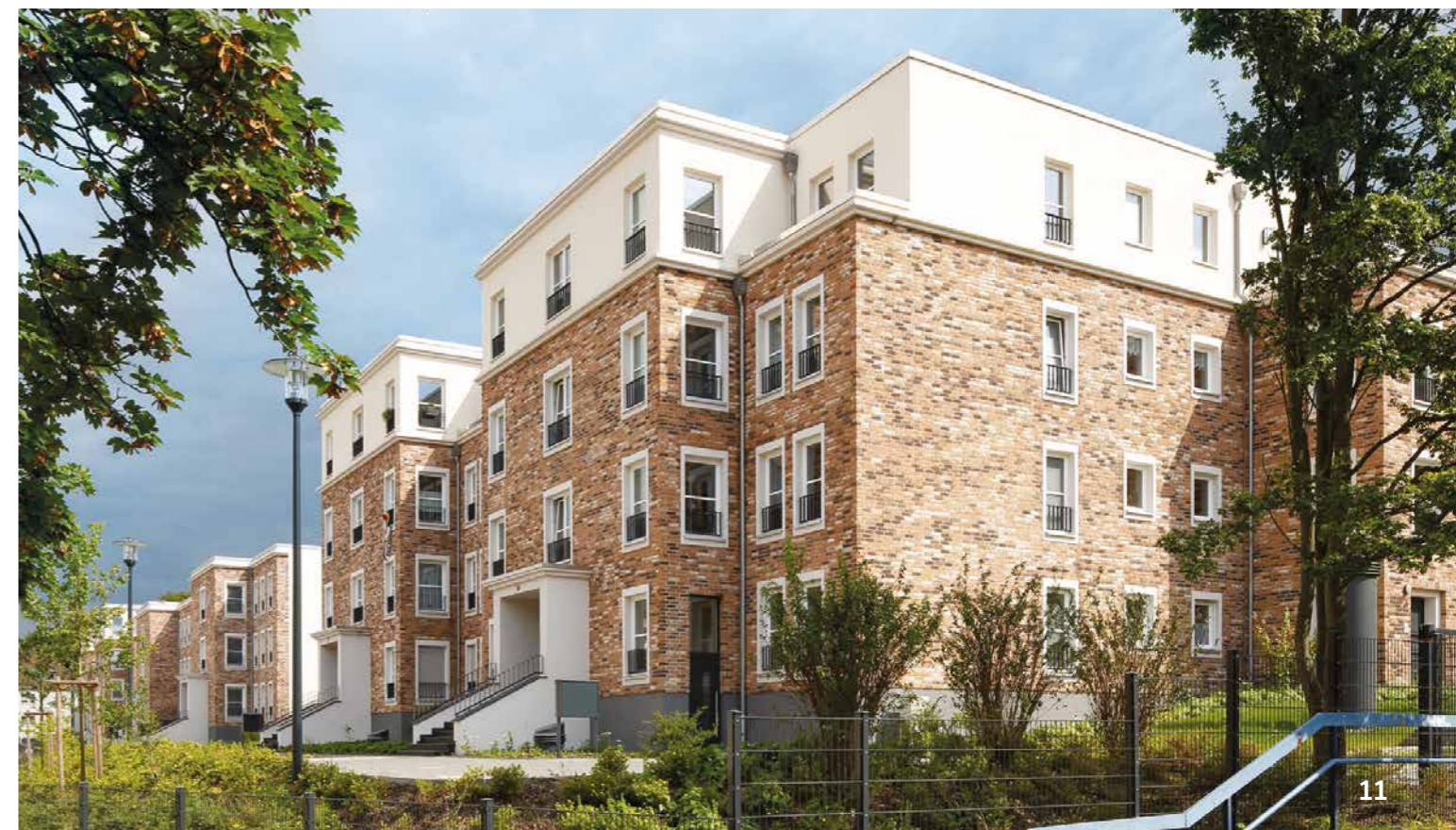
Cooler Rustikalität: Wohnanlage in Hagen mit Handform-Riemchen MOORBRAND torf-bunt
